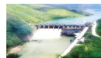
湖南沅天河水库 Hunan Centianhe Reservoir
