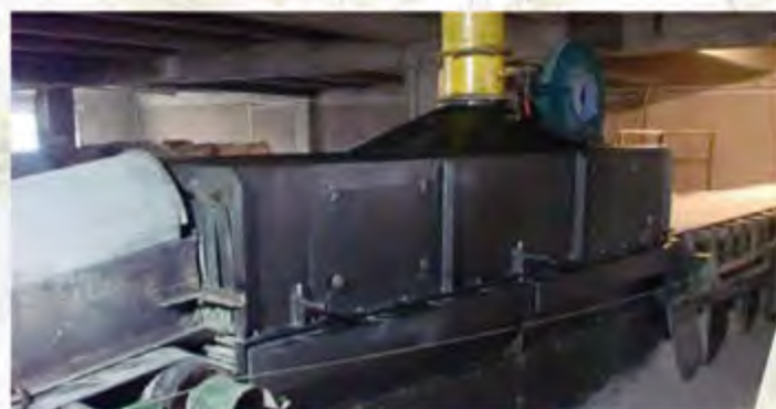
南通公司通过安装辊道清包机，装包车间现场无组织排放得到有效的改善
